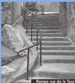
Rampe rue de la Tour
