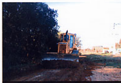
La Sagne : réfection des chemins
