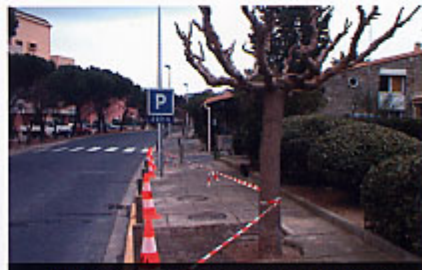
Boulevard de la Corderie : rénovation du trottoir
