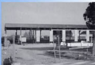
▲ Mateille : construction de la nouvelle caserne des pompiers
