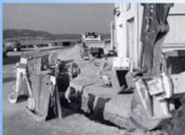
▲ Village : début des travaux de mise hors d'eau
