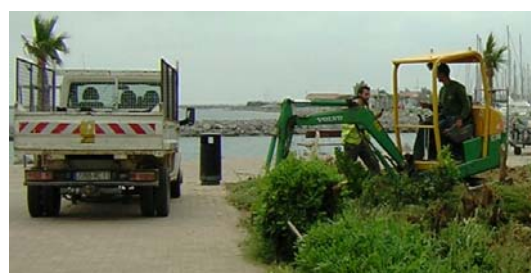
Réalisation par les services techniques municipaux de travaux demandés par les résidents auprès des CDQ
