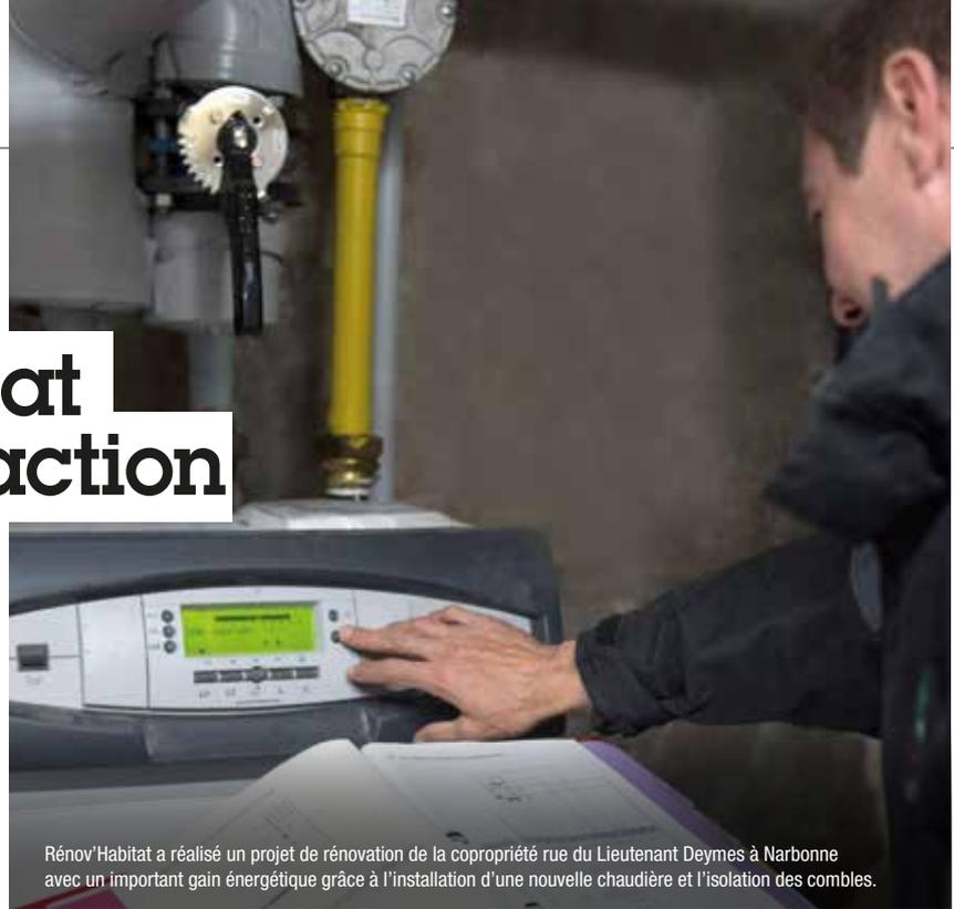
Rénov'Habitat a réalisé un projet de rénovation de la copropriété rue du Lieutenant Deymes à Narbonne avec un important gain énergétique grâce à l'installation d'une nouvelle chaudière et l'isolation des combles.
