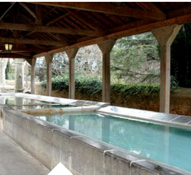
Le lavoir couvert, à Bizanet, pour le bonheur des lavandières aujourd'hui occasionnelles...
