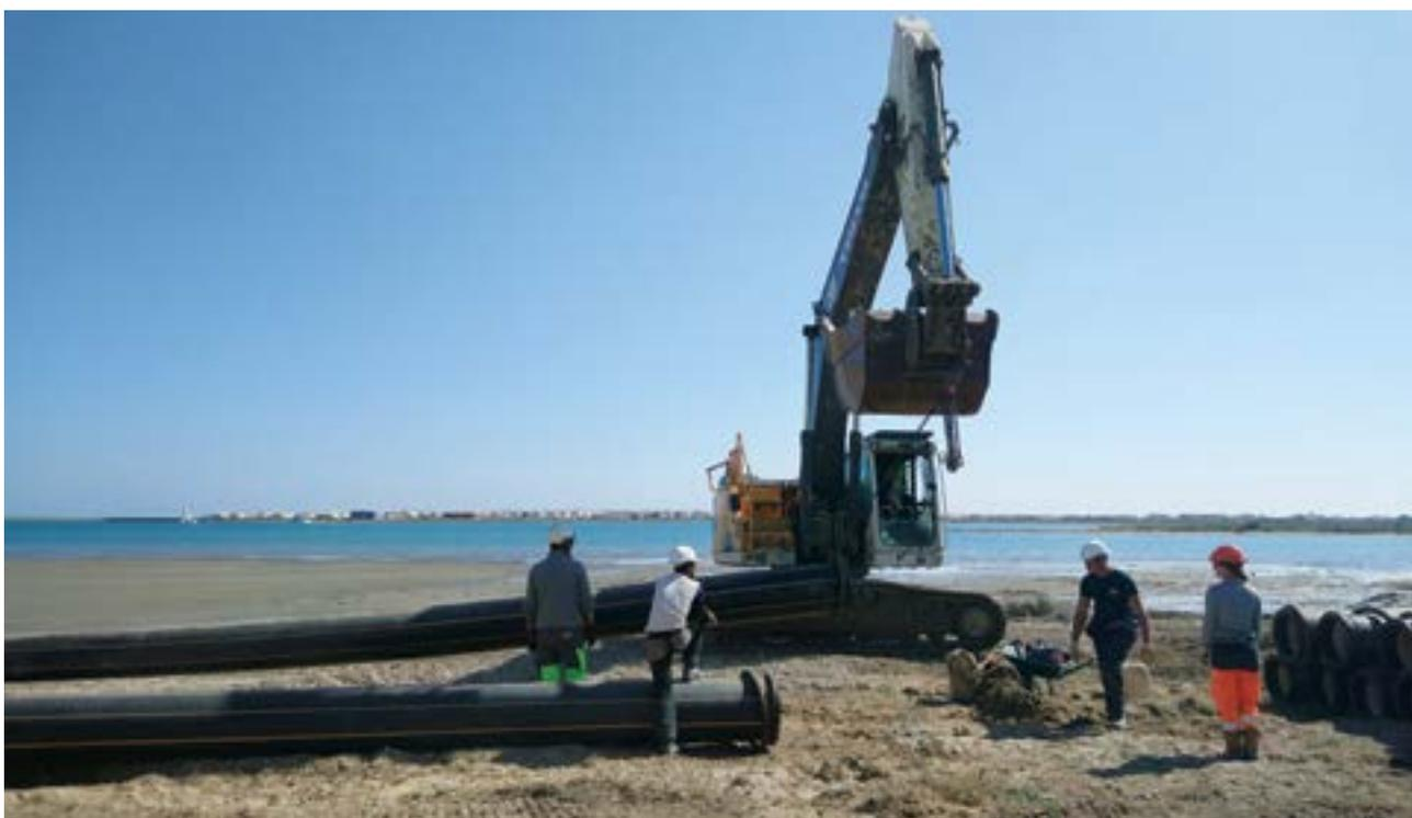
En mars 2019, l'entreprise BUESA TMF a effectué le dragage d'entretien de 20 000 m<sup>3</sup> de sédiments entre l'île aux oiseaux et la plage du Grazel. Une drague a aspiré les sédiments et les a refoulé via une conduite flottante en pieds de la promenade du Grazel. A l'aide d'une pelle mécanique, l'entreprise a formé un merlon de sable qui a participé à la protection de la promenade en sus des enrochements.
